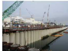
海側遮水壁打設完了の様子
