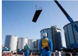
溶接タンク建設中の様子
