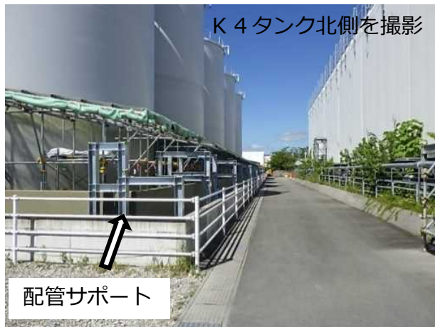
循環配管サポート設置の状況
