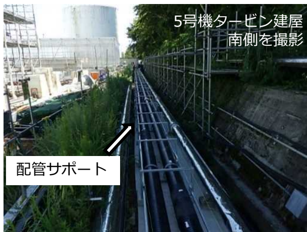
移送配管サポート設置の状況
