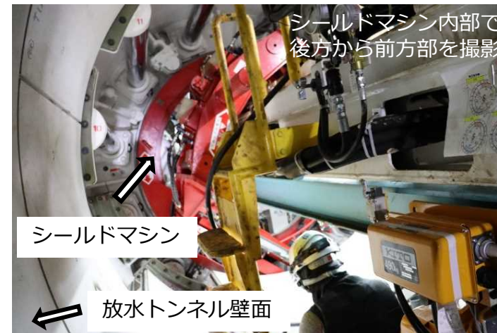
シールドマシン掘進作業の状況
