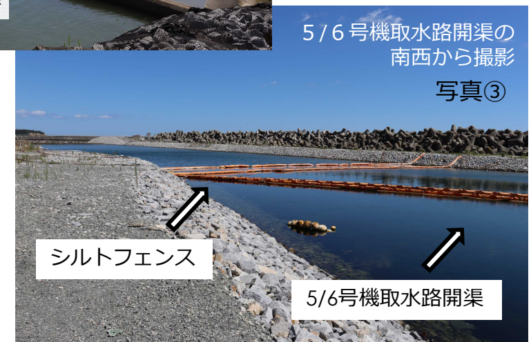
5・6号機海側工事エリアの状況
