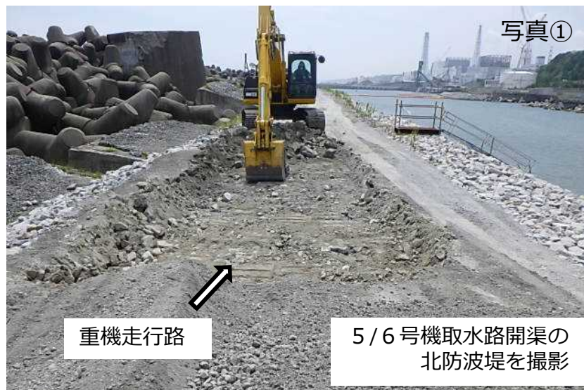
重機走行路整備の状況
