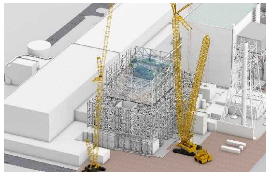
下部架構設置完了
