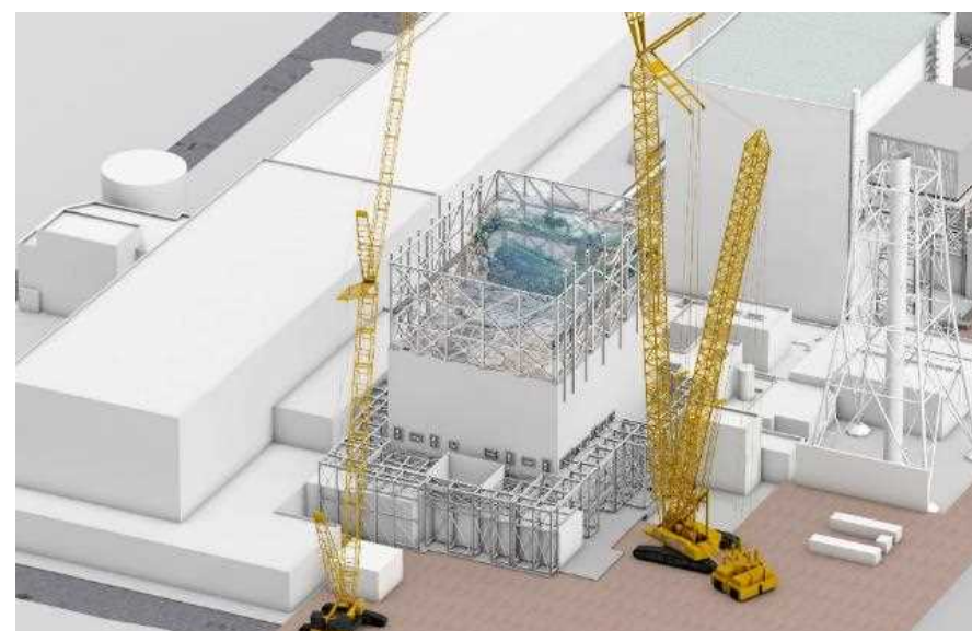
仮設構台設置完了
