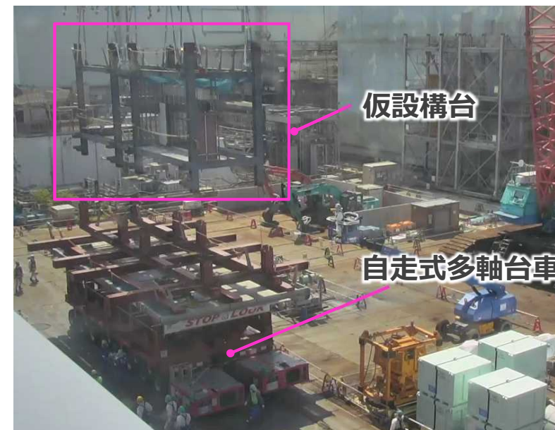
仮設構台運搬状況（北西） (撮影：2022年8月8日)
