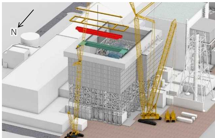
ガレキ撤去用天井クレーン設置中
