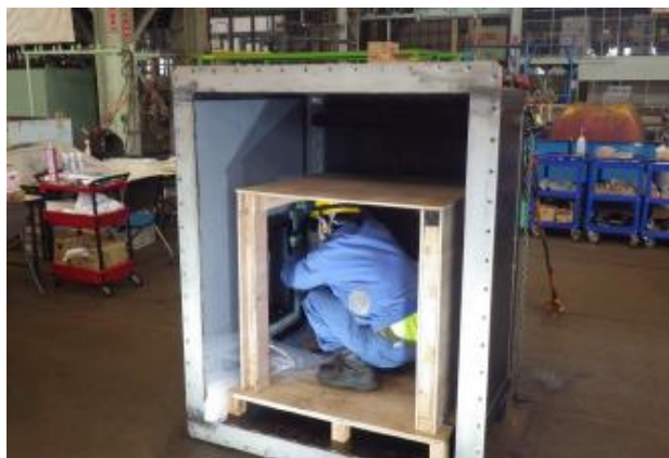
金属板取付け
