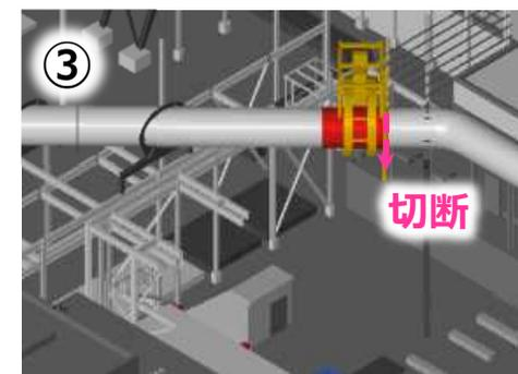
③ ワイヤソーで主排気ダクト1ブロック目の1Bブロック2号機側の切断を行う
