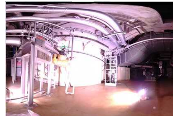
3階シェル壁北東面（写真）
