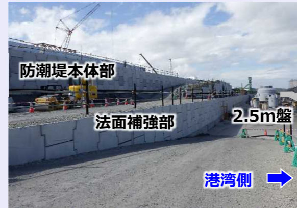
<防潮堤本体施工の様子>
