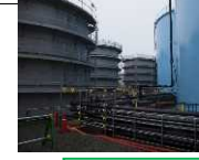
海側遮水壁打設完了の様子
