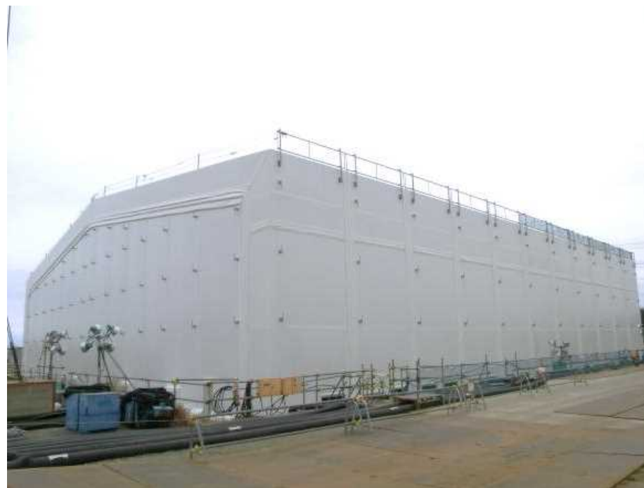
既設多核種除去設備(既設ALPS)
