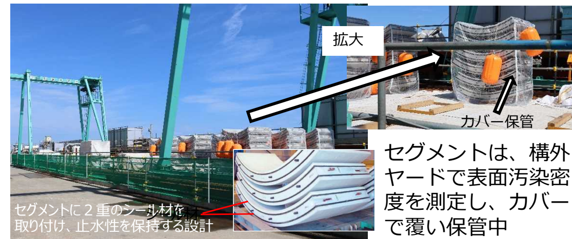
セグメント保管状況
