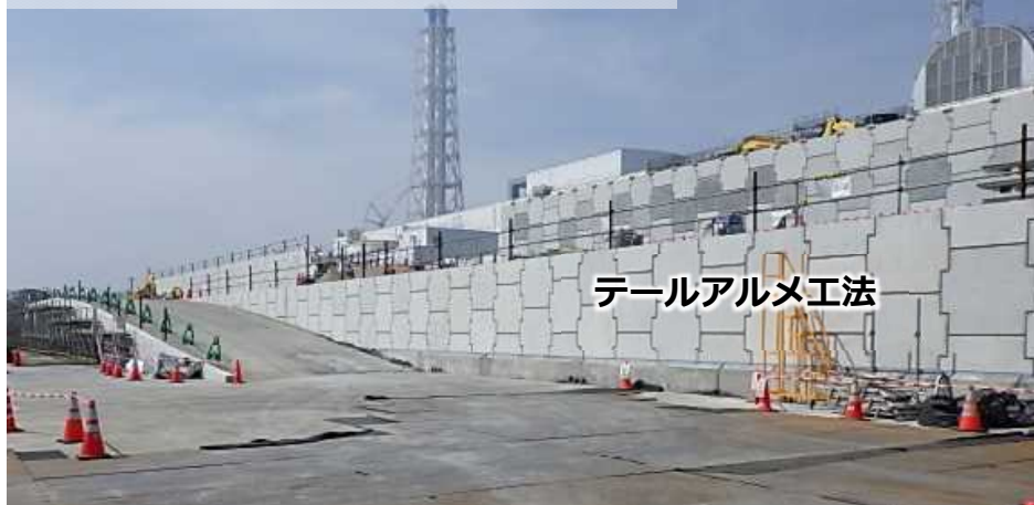
コンクリート壁設置状況
