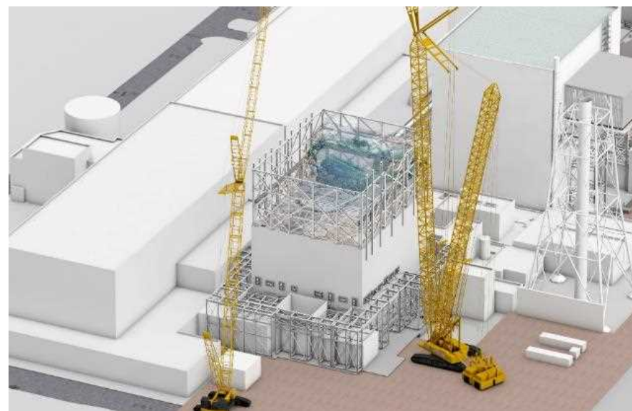
仮設構台設置完了
