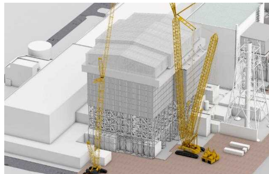
可動屋根設置完了
