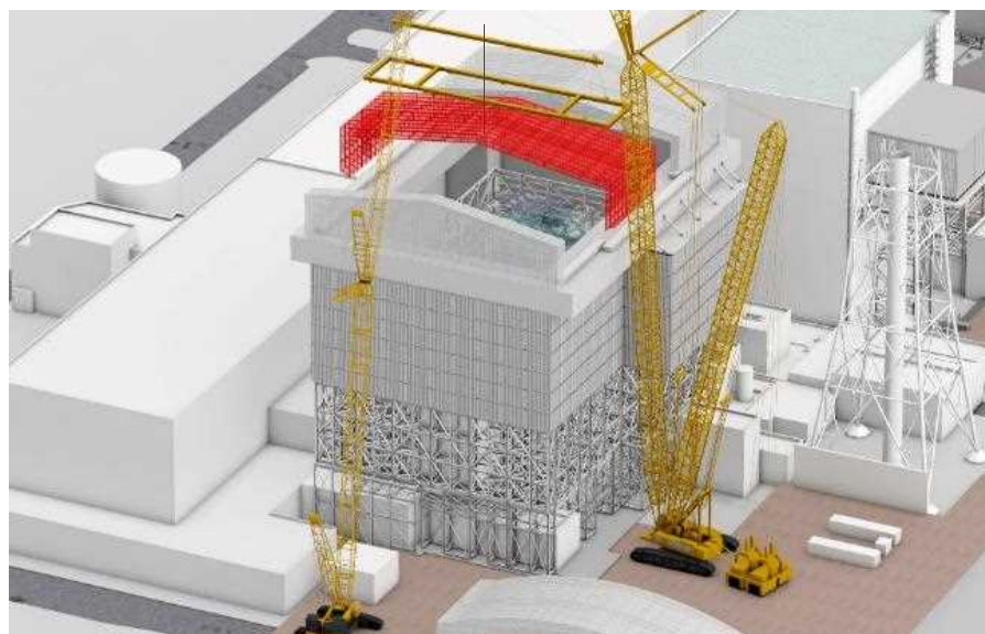
可動屋根設置中
