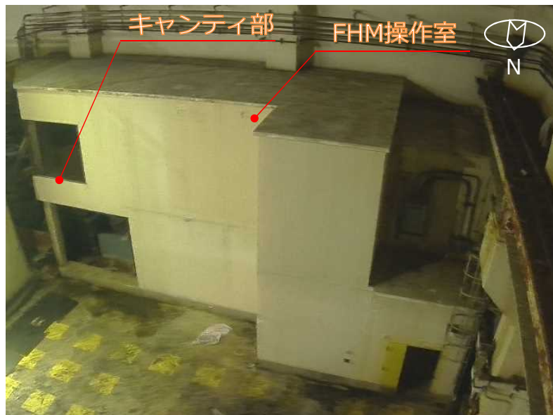
FHM操作室撤去前
