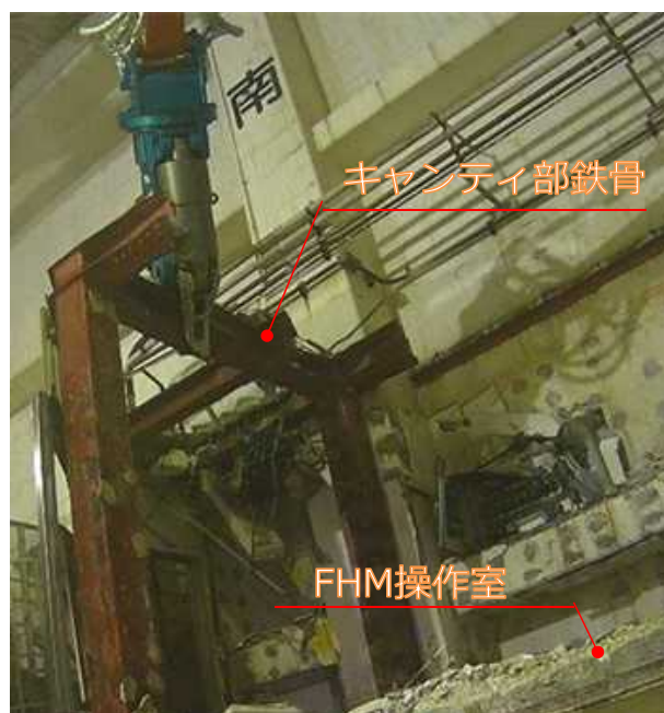
部鉄骨撤去作業時の状況
