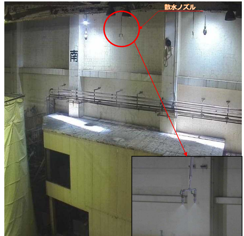
散水設備設置写真（ダスト飛散対策）
