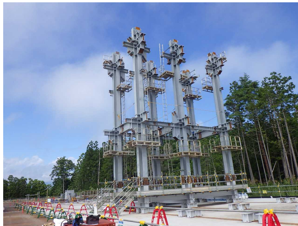
鉄骨地組作業状況（撮影：2022.9.7）
