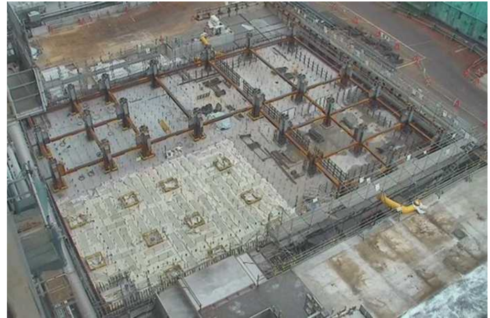
2号機原子炉建屋南側ヤード全景 (撮影：2022.9.10)
