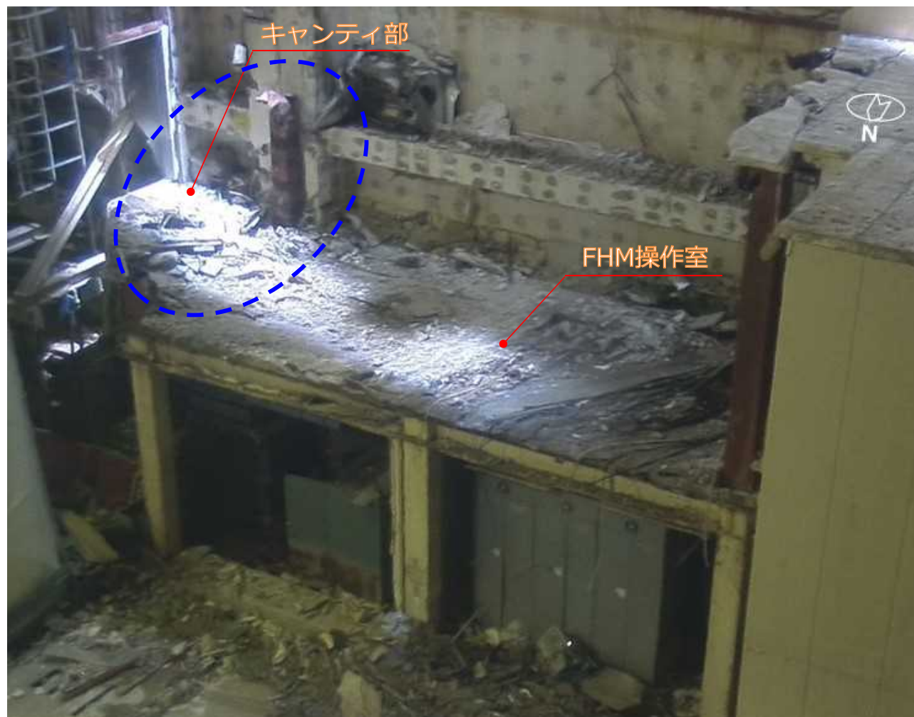
撤去作業状況 (9月22日撮影)
