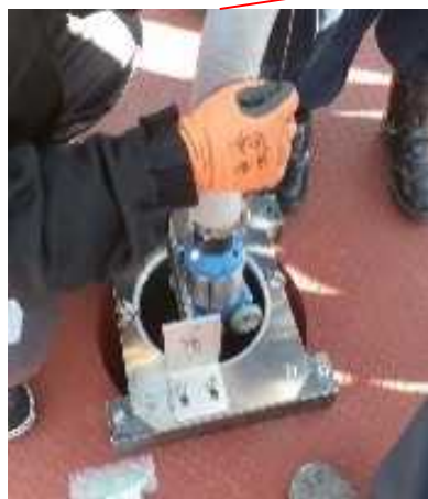
配管内アクセス装置挿入(3階)
