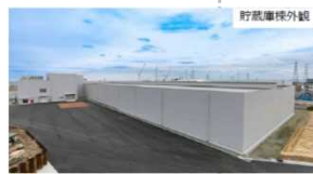
固体廃棄物貯蔵庫第9棟外観
