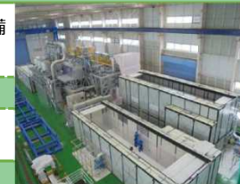
大型機器除染設備 外観
