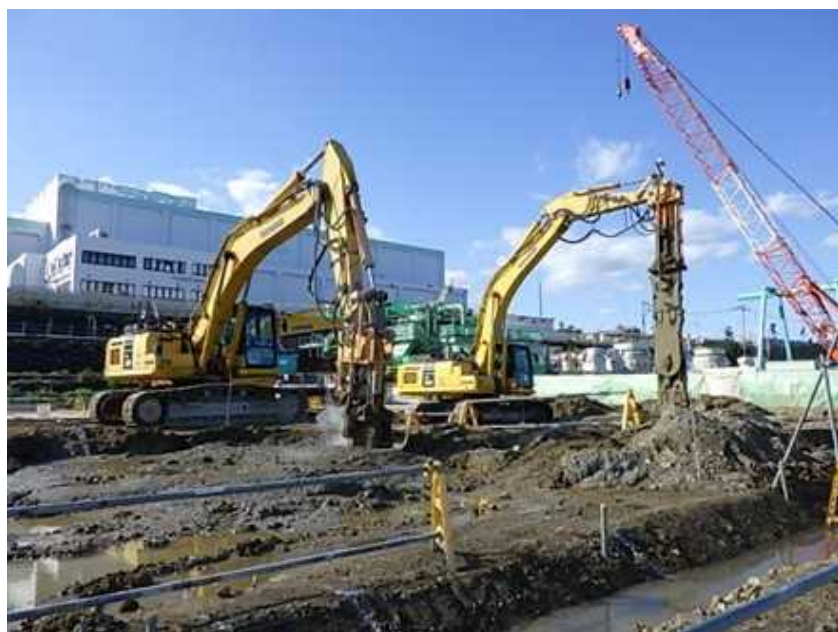
地盤改良の状況
