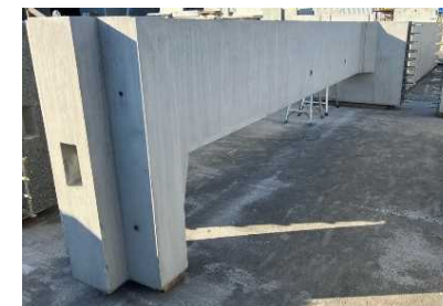
上流水槽隔壁
