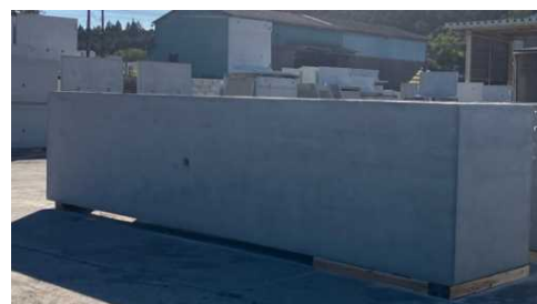
上流水槽側壁
