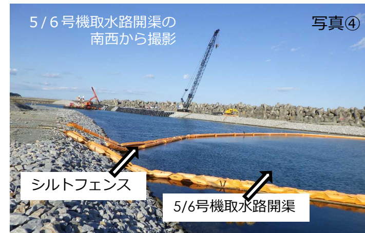
5・6号機海側工事エリアの状況
