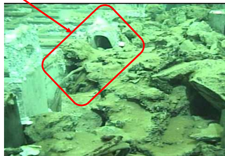
吊りピース変形
