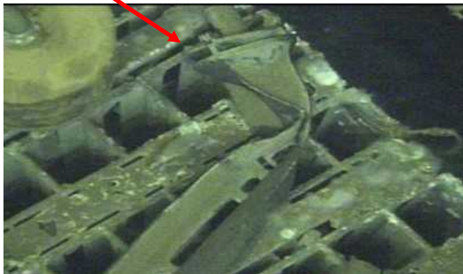
制御棒下部に変形
