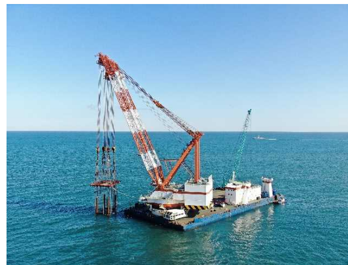
放水口ケーソンの据付工事の様子④
