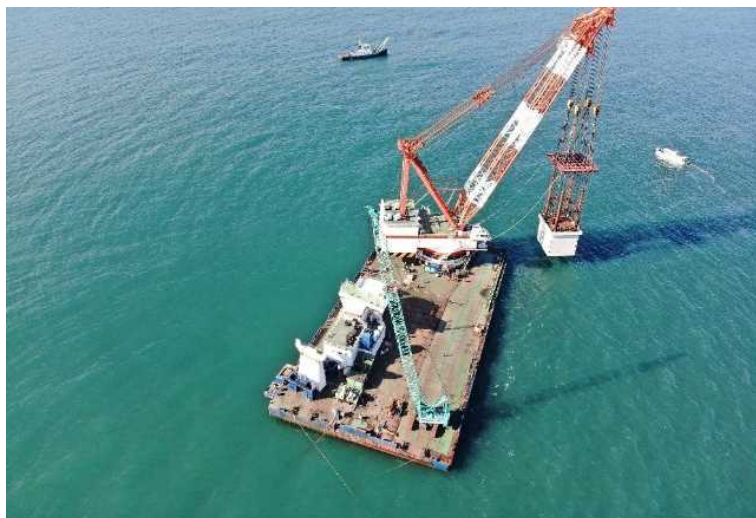
放水口ケーソンの据付工事の様子①
