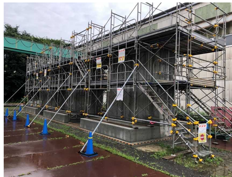
写真1. 試験体構築完了
