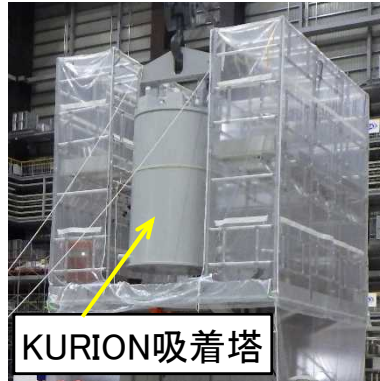
実吸着塔の遠隔設置
