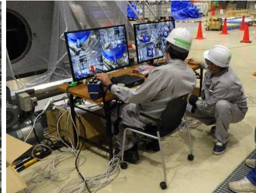
実吸着塔の遠隔設置
