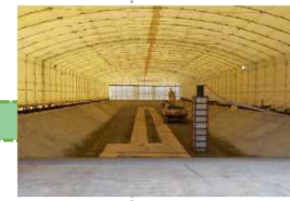
覆土式一時保管施設第3槽全景
