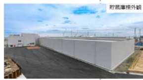
固体廃棄物貯蔵庫第9棟外観
