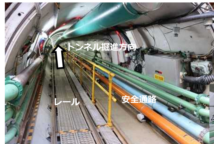
トンネル内部安全設備の整備状況
