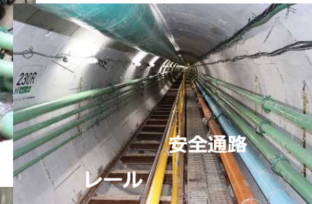
トンネル内部安全設備の整備状況
