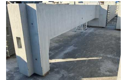
上流水槽隔壁
