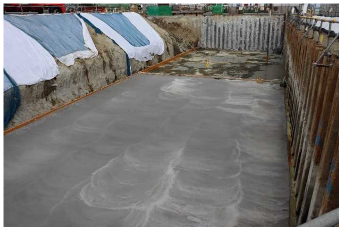
均しコンクリート打設の状況
