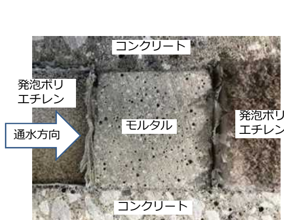
(1) モルタル 気中打設の切断面
