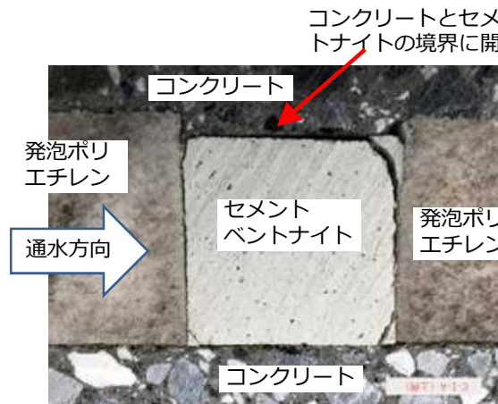
(2) セメントベントナイト 気中打設の切断面
