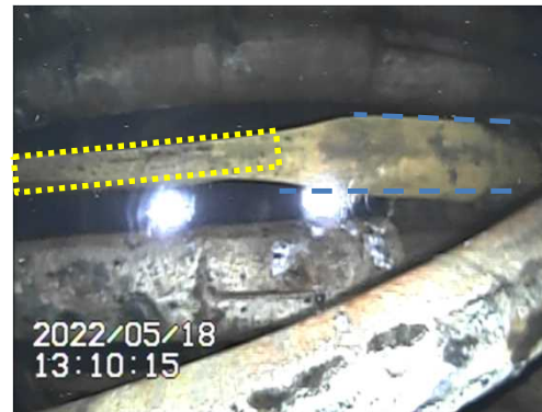
水面より上のRCW配管の状況
