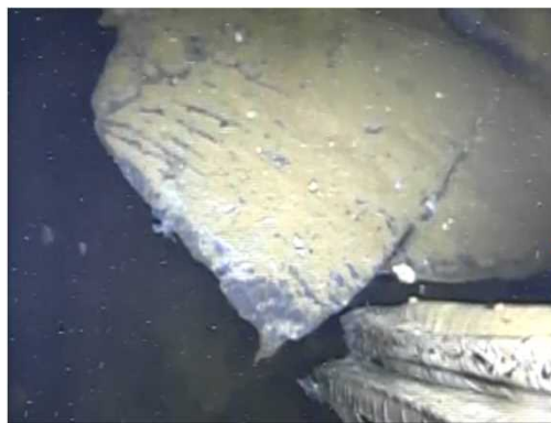
E: 真空破壊弁からの水漏れが確認された ベント管のジェットデフレクター
