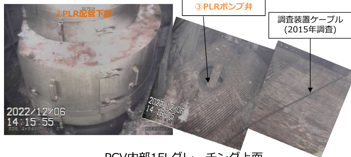
PCV内部1FLグレーチング上面
