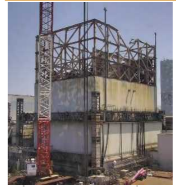
<1号機 残置カバー解体中の様子>
