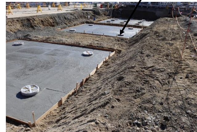
海水移送配管基礎の構築状況
