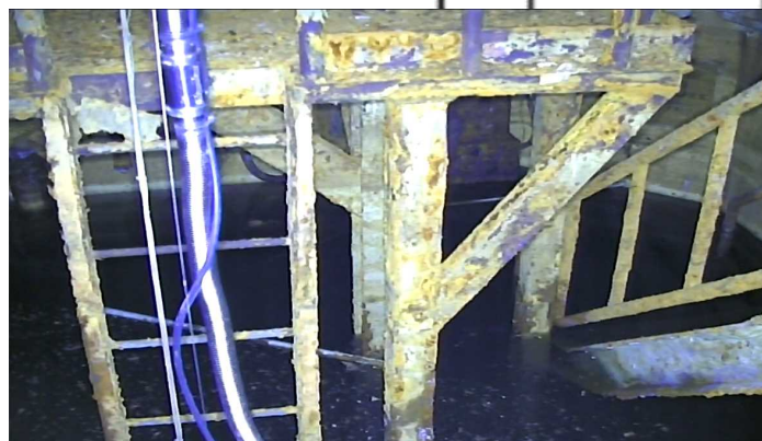
②西 (階段、空調設備)
