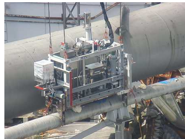
写真：2021年9月ウレタン注入時
