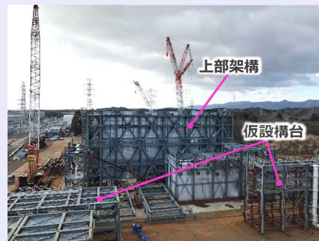
＜鉄骨地組作業の様子（撮影日：2023.2.20）＞
