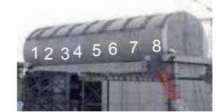
<3号機 燃料取り出し用カバー（ドーム屋根）2019/2/21撮影>
