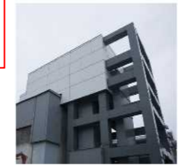
<4号機 燃料取り出し用カバー>
