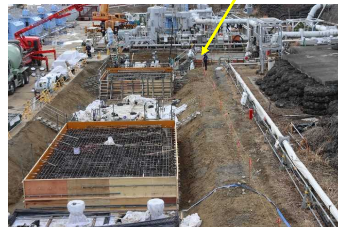
海水移送配管基礎の構築状況
