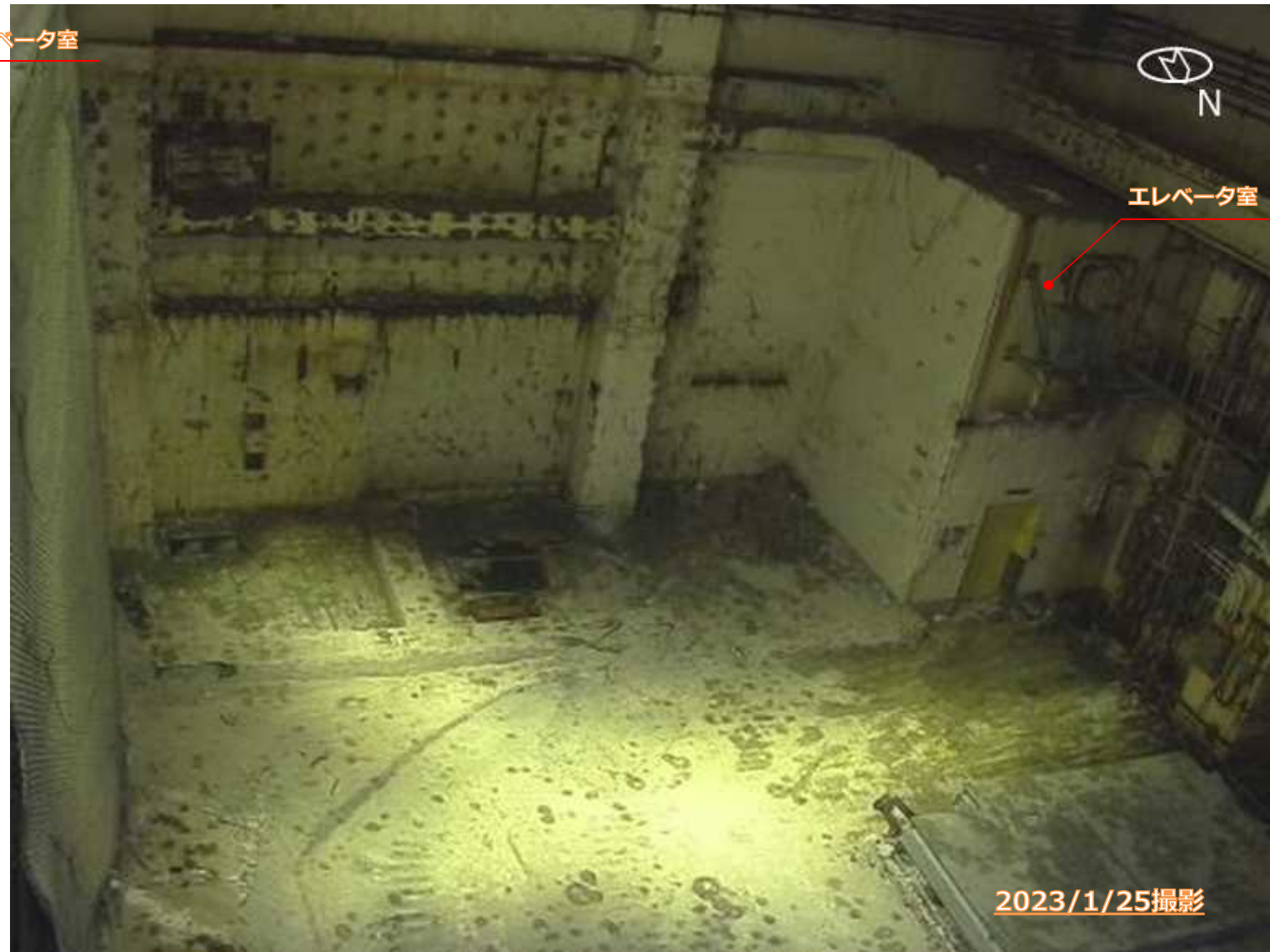
解体後の現場状況写真
