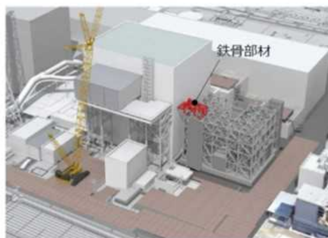
⑤構台鉄骨建方(3層目開始)
