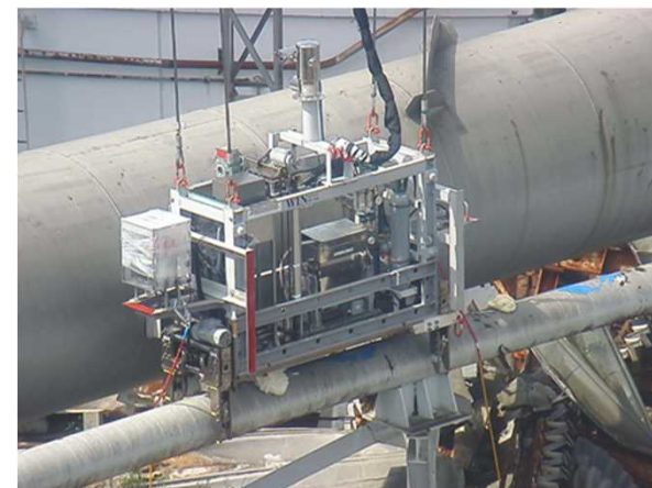
写真：2021年9月ウレタン注入時
