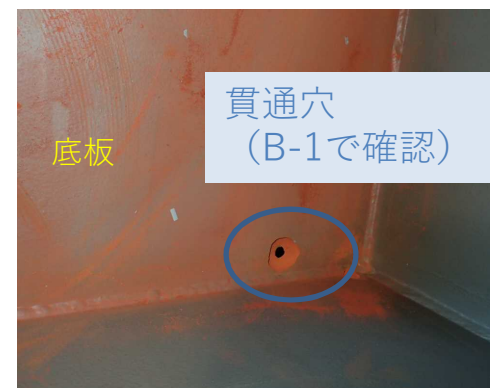
ケーシング底板の貫通穴
