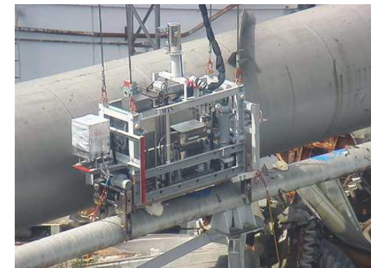
写真：2021年9月ウレタン注入時
