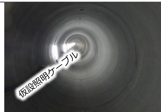
排水路推進トンネル完成状況
