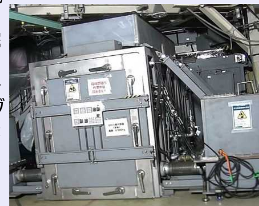
＜隔離部屋据付の状況＞
