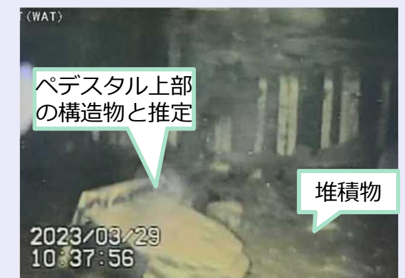
＜ペDESTAL底部の状況＞
