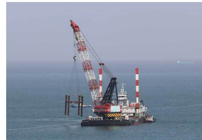
測量櫓（下段）撤去状況
