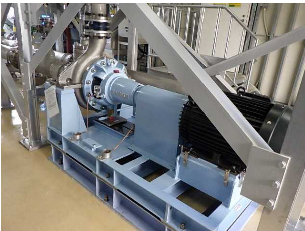
循環ポンプ設置の状況
