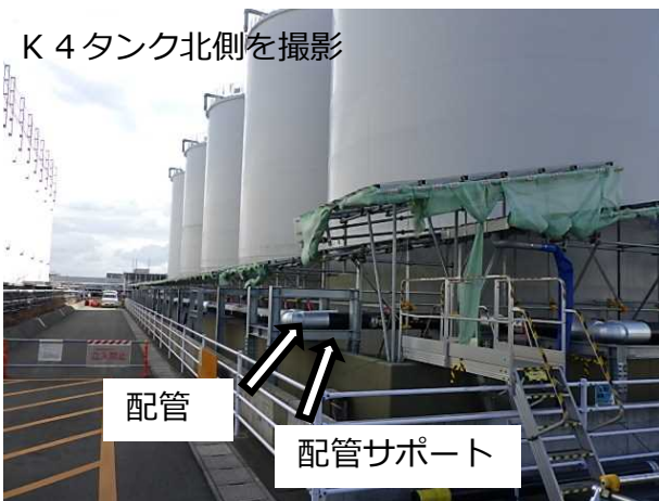
循環配管・サポート設置の状況
