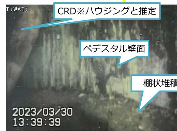
写真3. ペDESTAL内の棚状堆積物と壁面部
