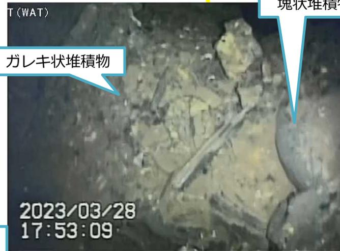
写真3.ペDESTAL内開口付近堆積物
