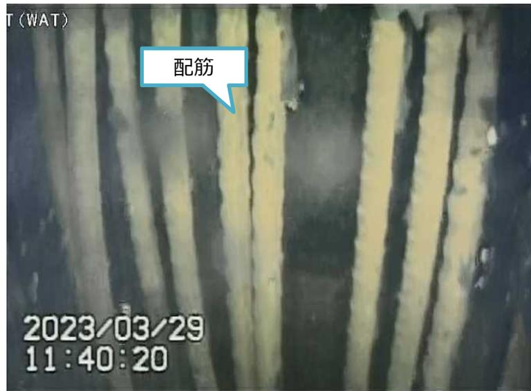
写真2.ペDESTAL内壁面部(下部)
