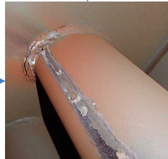
①バグフィルタ逆洗用圧縮空気配管と天板の付根部
