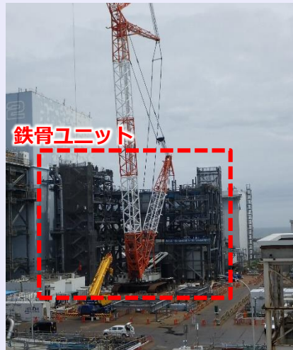
<鉄骨ユニットの組立の様子(5月16日時点)>
