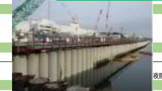
海側遮水壁打設完了の様子
