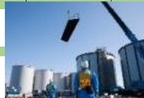
溶接タンク建設中の様子
