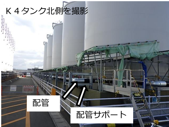
循環配管・サポート設置の状況
