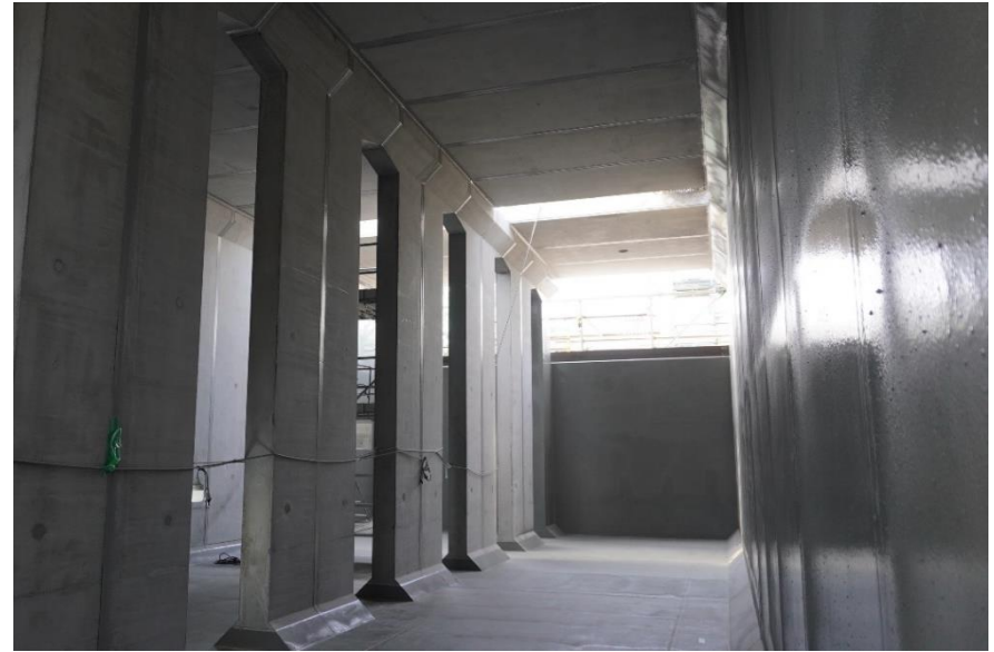
内部の状況（防水塗装完了）
