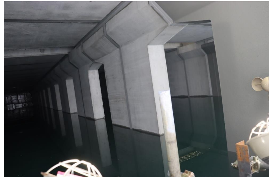
内部の状況（注水完了）
