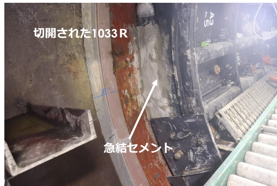
トンネル先端状況（止水工事の状況）
