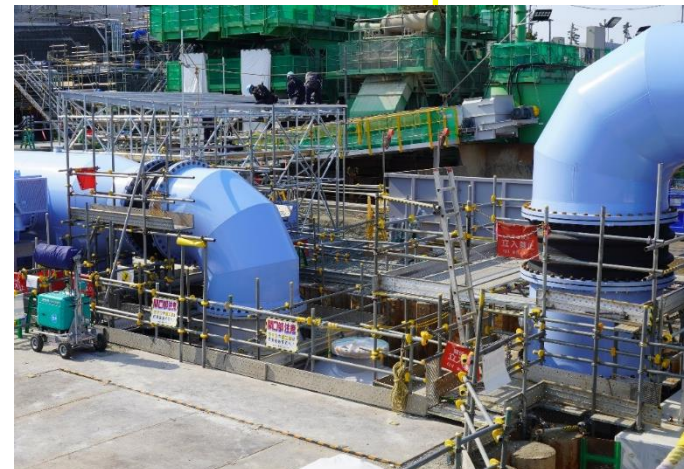
海水移送配管・海水配管ヘッダ設置の状況
