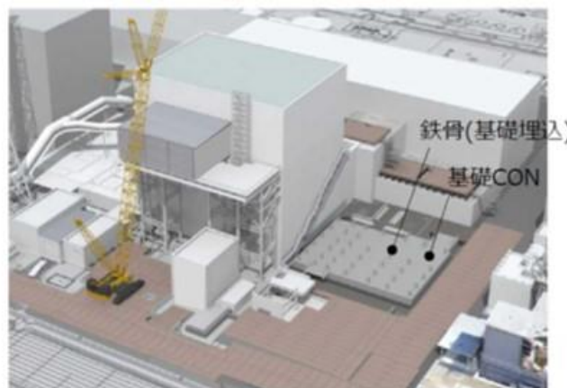
②構台鉄骨建方(0層)・基礎CON打設完了
