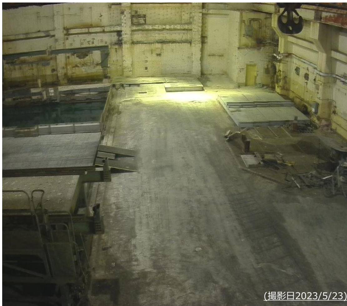
作業進捗状況
