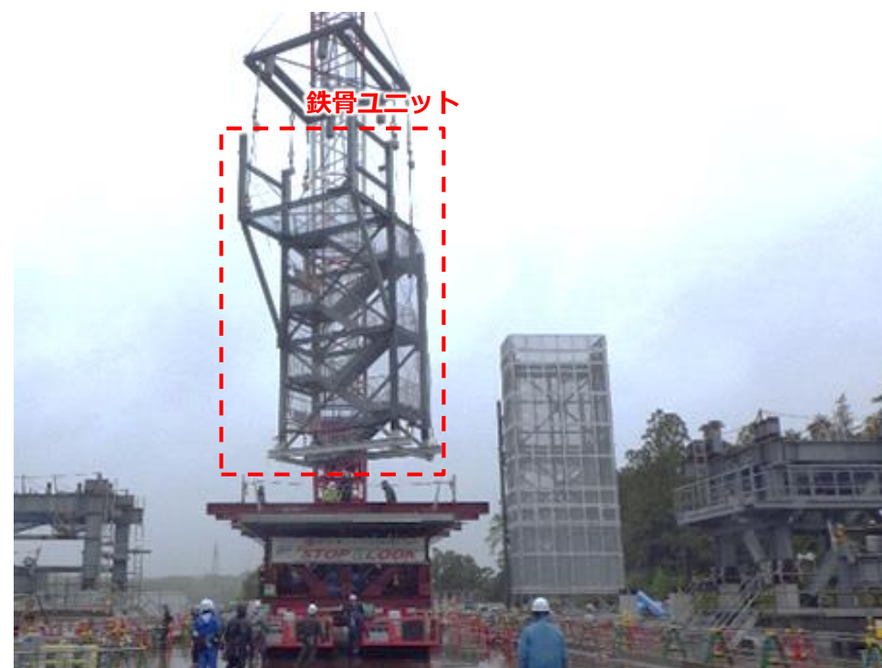
鉄骨ユニット運搬の実施状況（撮影：2023.4.26）
