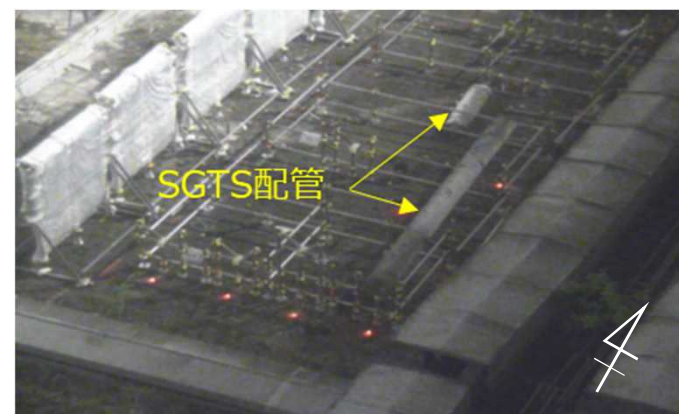
配管仮置き(1号C/B上)
