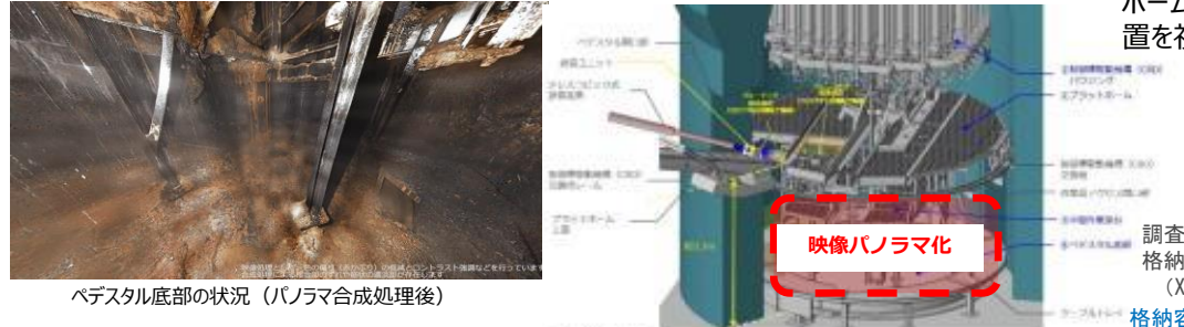
ベデスタル底部の状況（パノラマ合成処理後）
