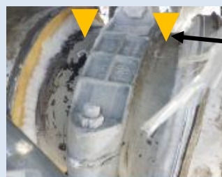
配管レベル計測箇所
