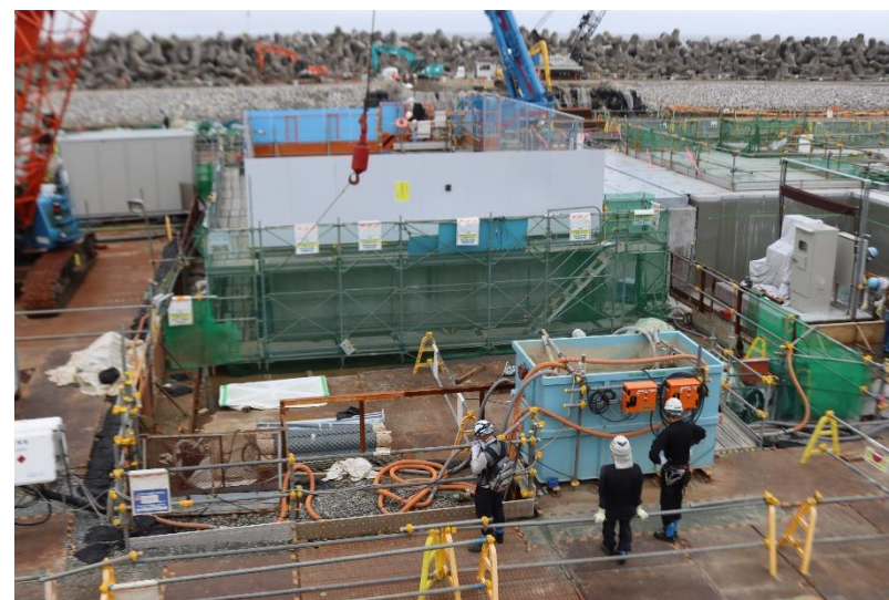
放水立坑（下流水槽） 全景
