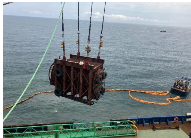
到達管の撤去作業の状況②
