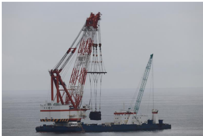
到達管の撤去作業の状況①
