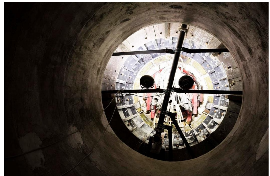
トンネル先端状況
