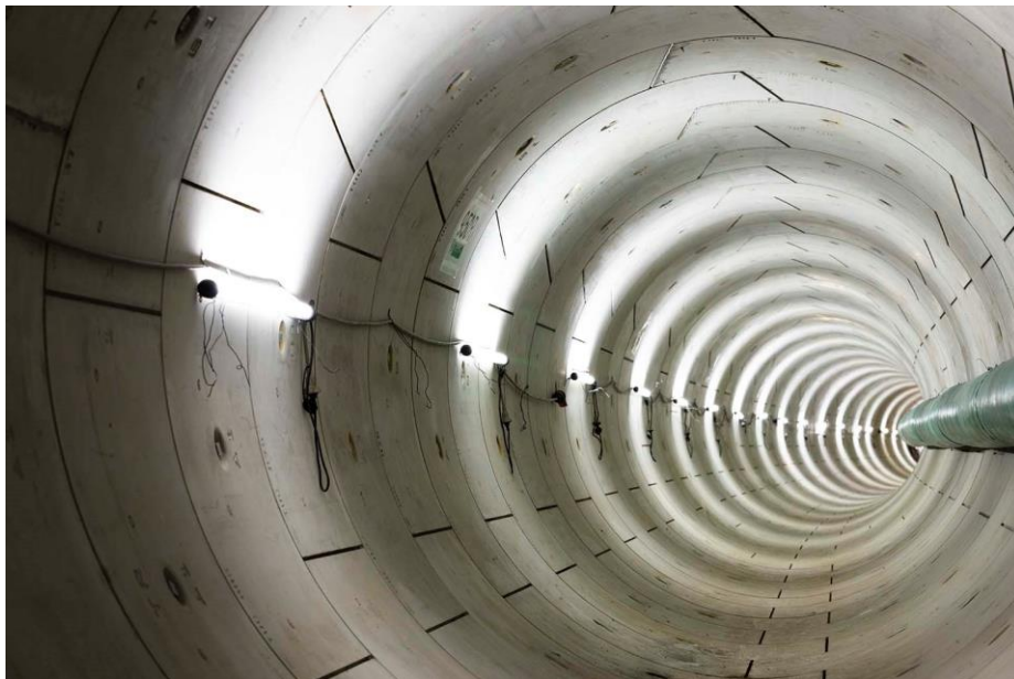
トンネル内部の状況
