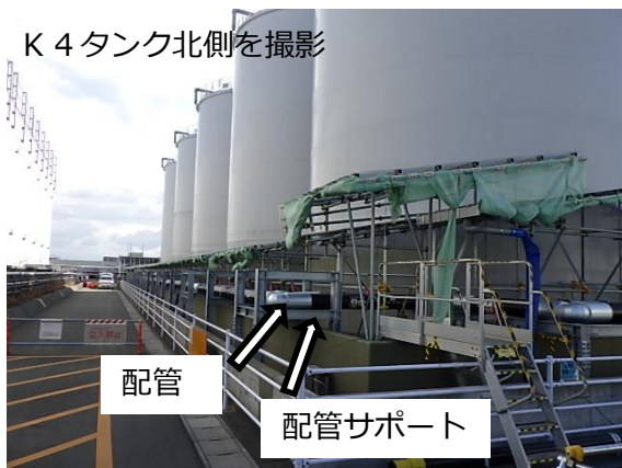
循環配管・サポート設置の状況
