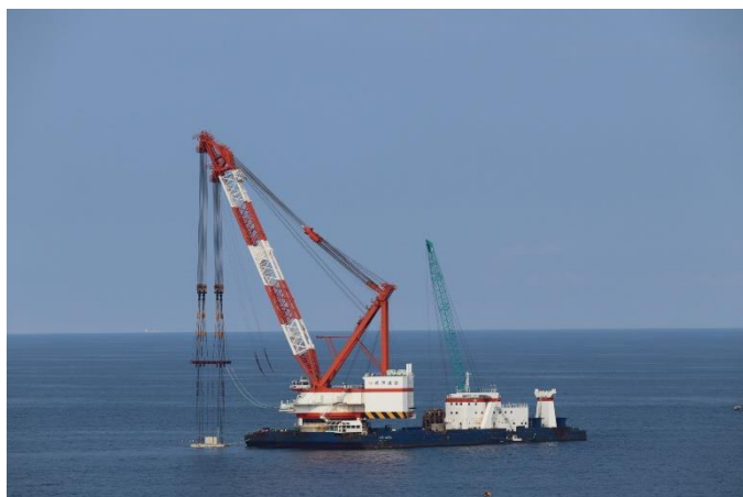
放水蓋設置作業の状況①
