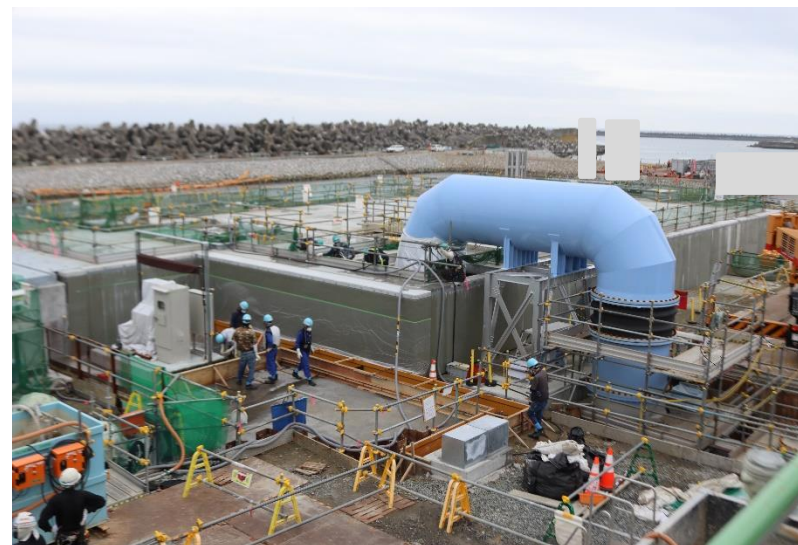
放水立坑（上流水槽） 全景
