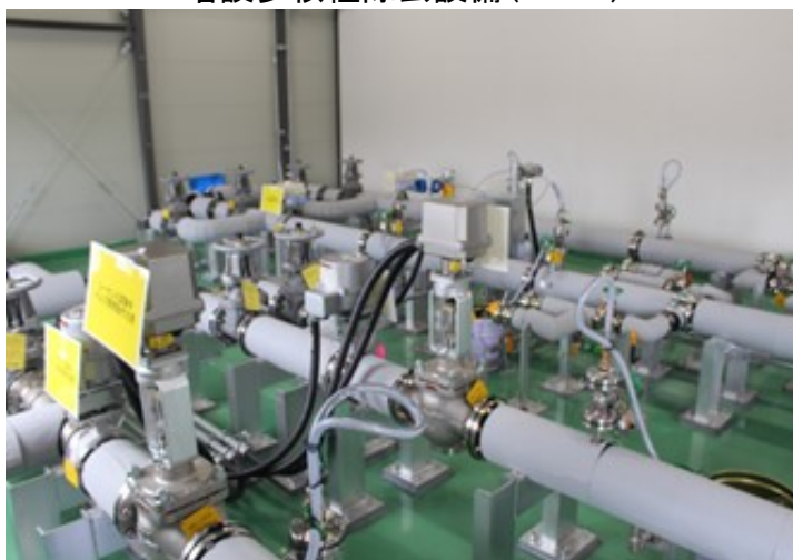
ALPS処理水移送設備 (緊急遮断弁)
