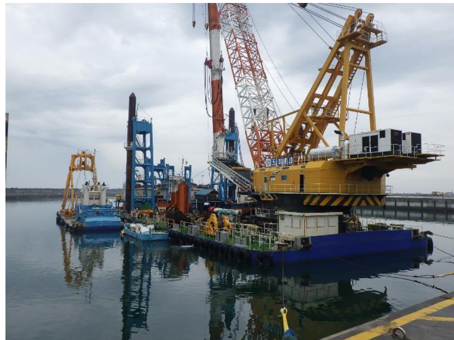
図2.作業船(物揚場での係留状況)
