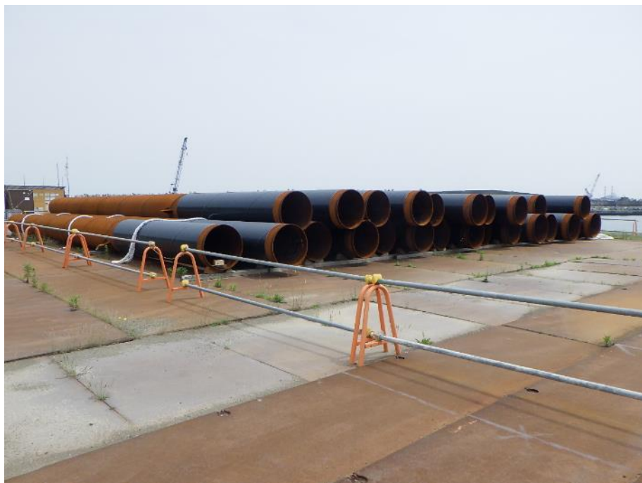
図1.鋼管杭(構内での仮置き状況)
